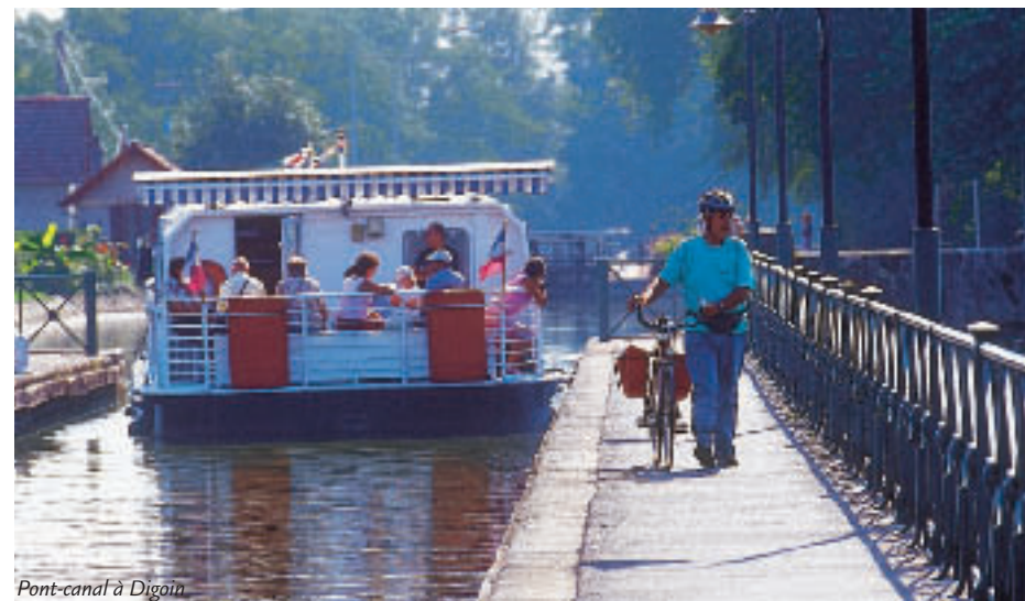
Pont-canal à Digoin
